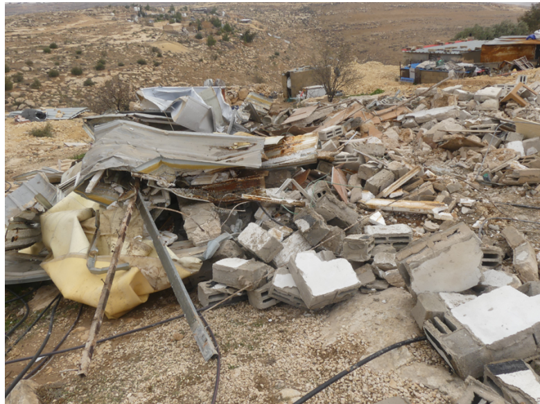
Figura 9: Khallet Athaba, 10 febbraio. Le macerie di una casa demolita
